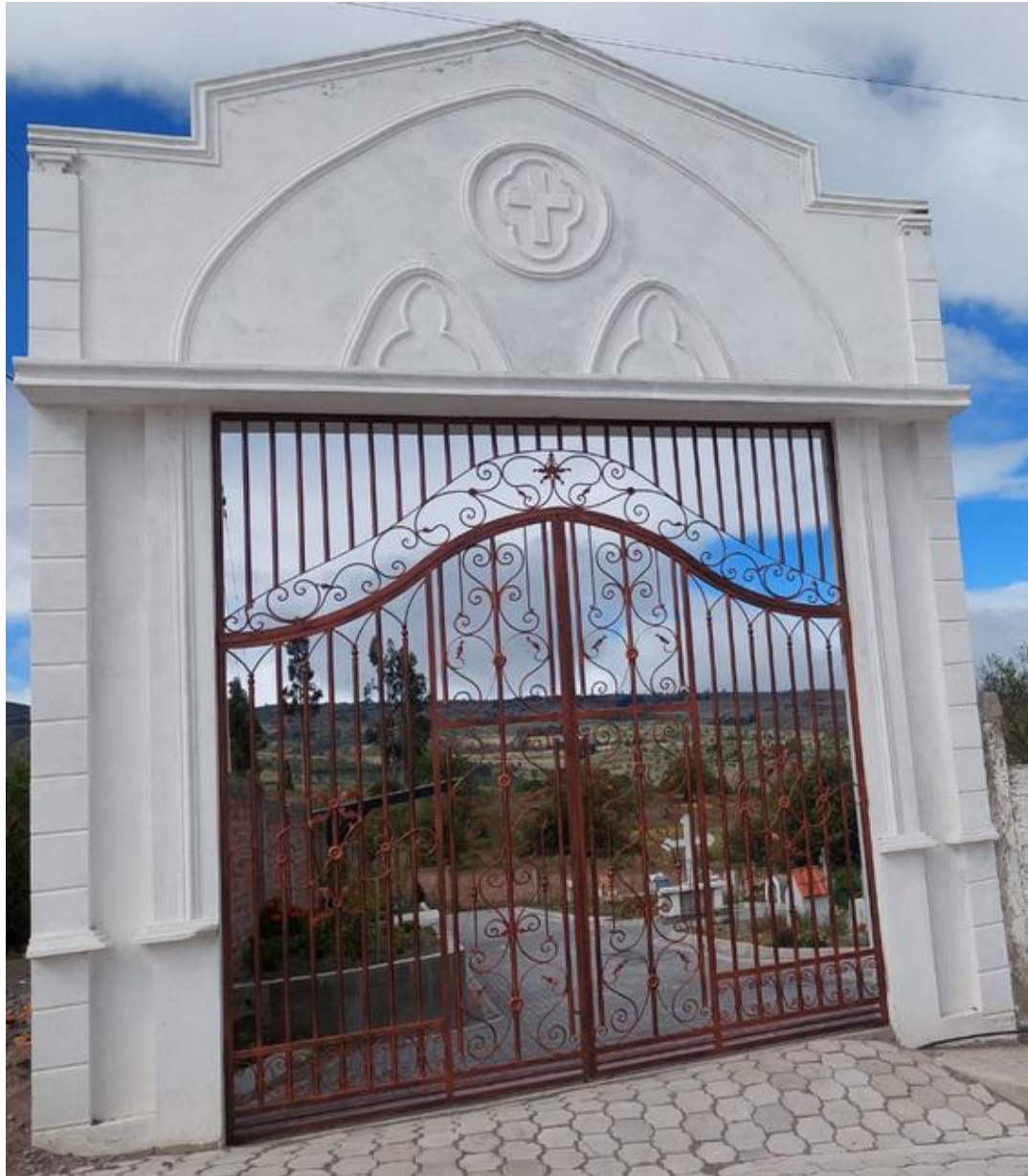
PUERTA DE INGRESO
