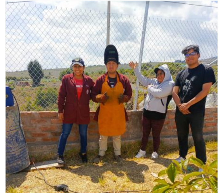
Colocación de la malla en el parque
